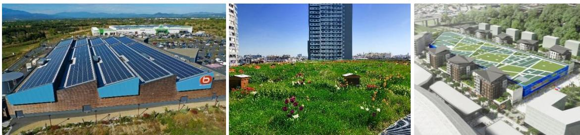
Photo de gauche, panneaux photovoltaïques sur les toits de Boulanger et Kiabi - Perpignan (66) – Production énergétique annuelle : 793 MWh pour un apport énergétique au bâtiment de 105 kWh/m<sup>2</sup>/an (bâtiment à énergie positive tout usage)
